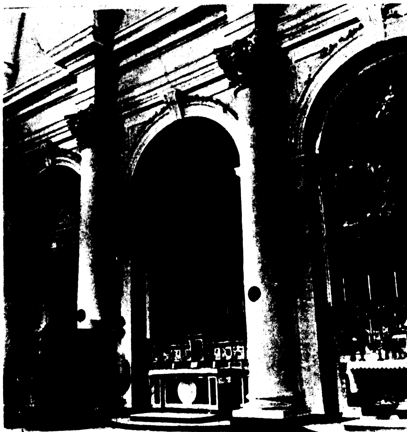
Mesagne, chiesa matrice, interno, particolare della fiancata. Si notano le colonne aggiunte da Nicola Carletti per poggiare la volta. (Fototeca Briamo)
