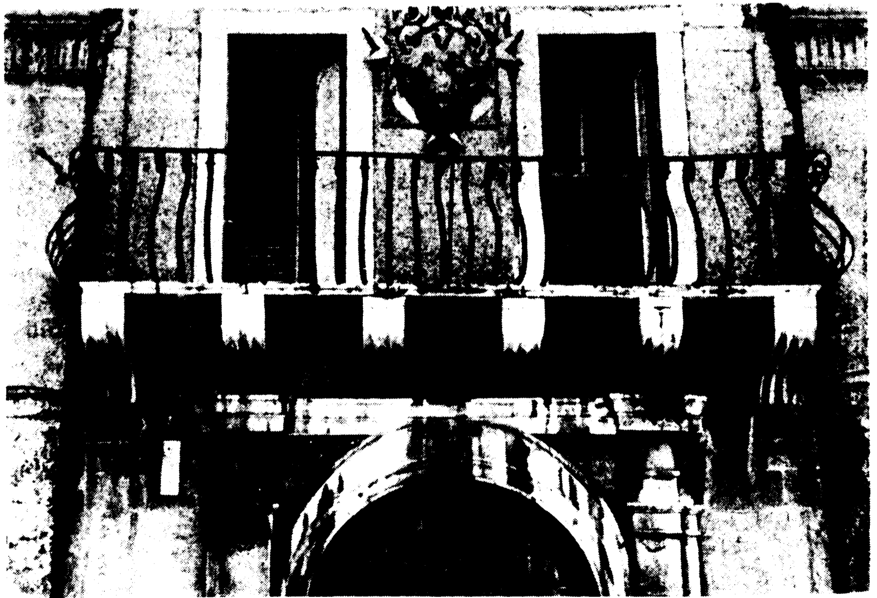
Brindisi, facciata del Seminario di Brindisi, loggia. ( Fototeca Briamo )
