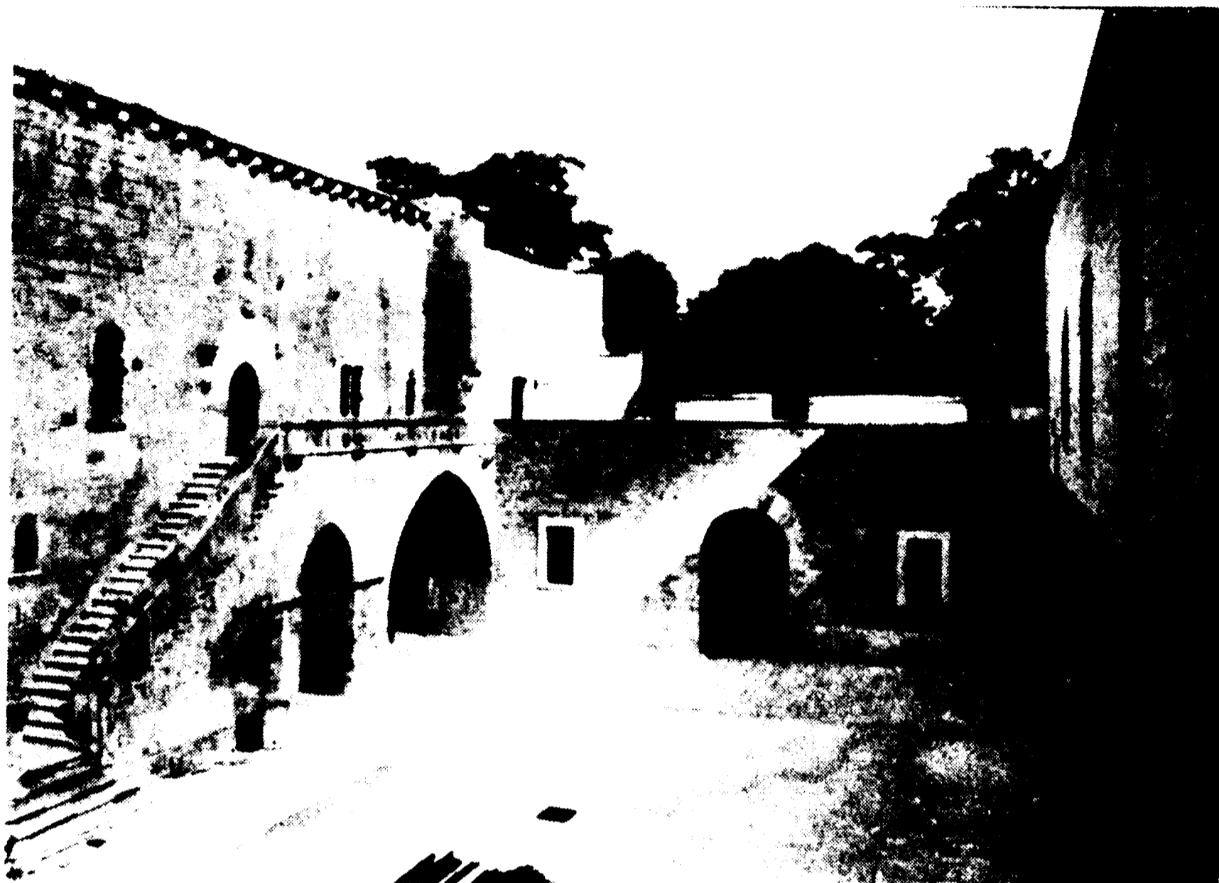
Fig. 5 - Castello di Gioia: Cortile-prospetto della cortina Nord dopo i restauri del De Vita.
