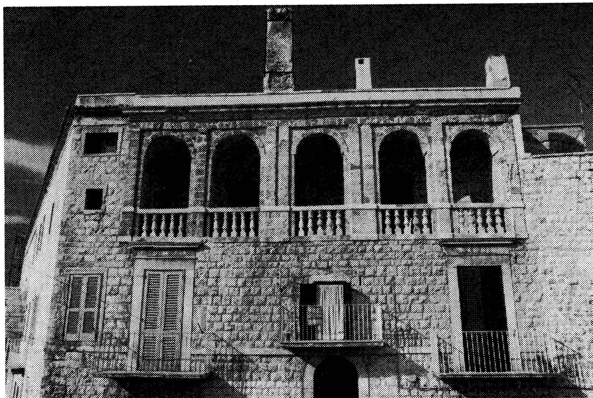
Fig. 9 - Molfetta, Palazzo Dogana, loggia sul lato meridionale.
