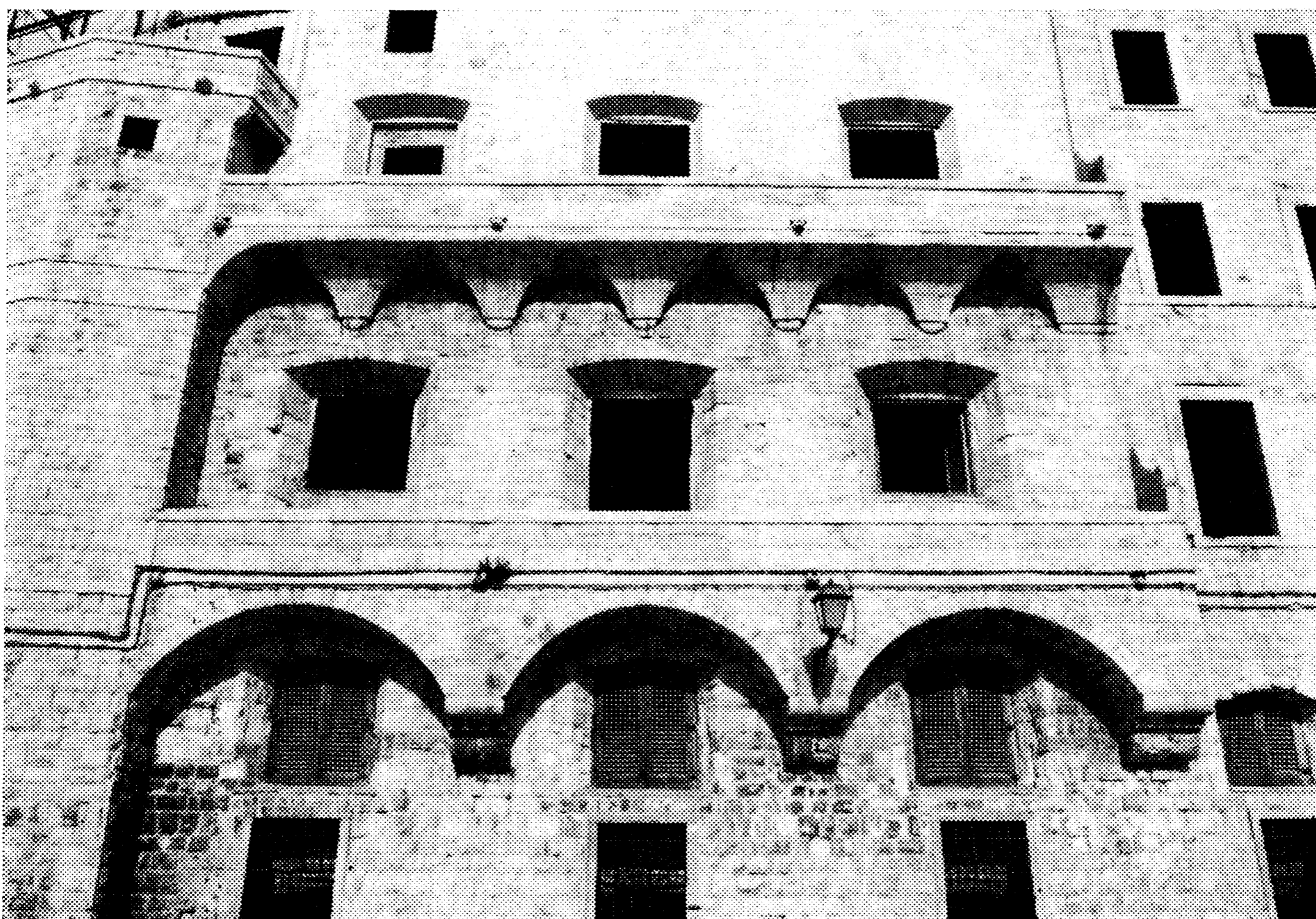
Fig. 7 - Molfetta, Palazzo Dogana, particolare della facciata occidentale.
