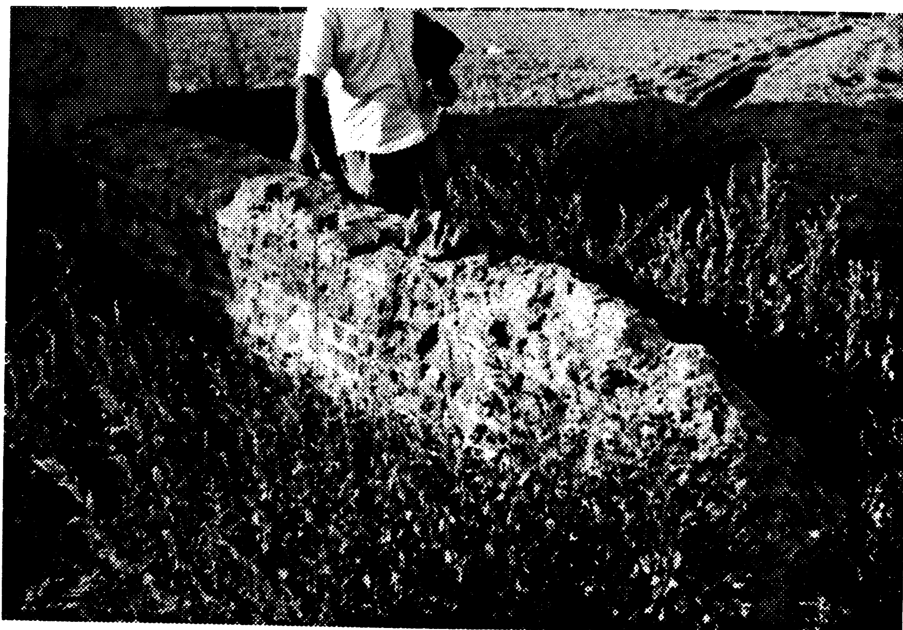
Fig. 9. Tratto di muro DE.
