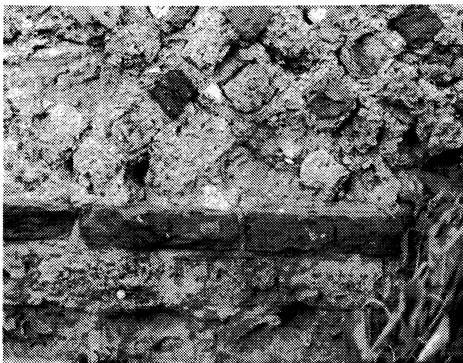
Fig. 11. Particolare tratto di muro FG.
