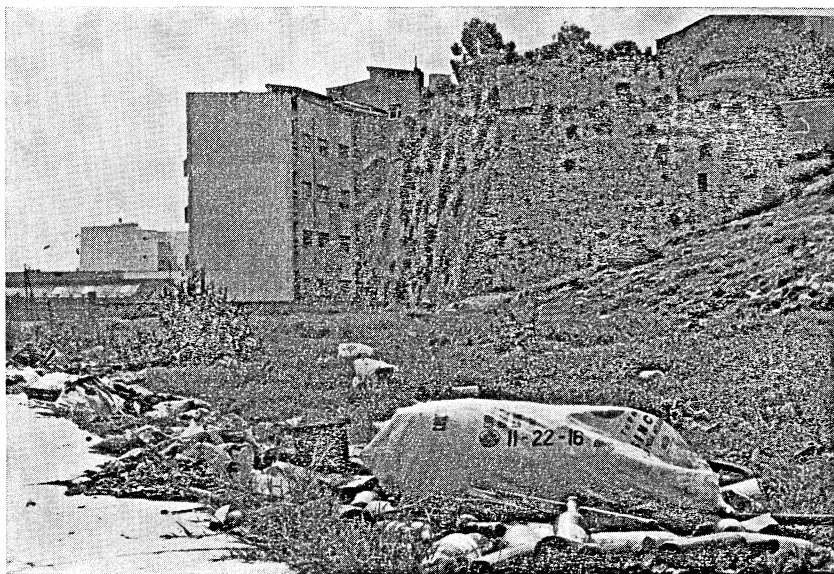
Brindisi: Via del Mare - Il Muraglione e largo prospiciente il terminal - traghetto per la Grecia.
