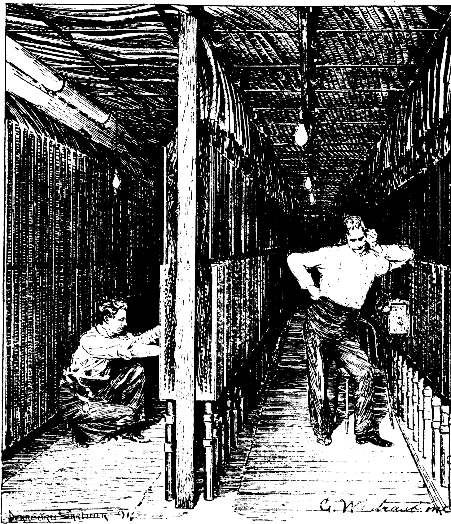
Una parte della sala sotterranea dell'Ufficio Cortlandt Street.
