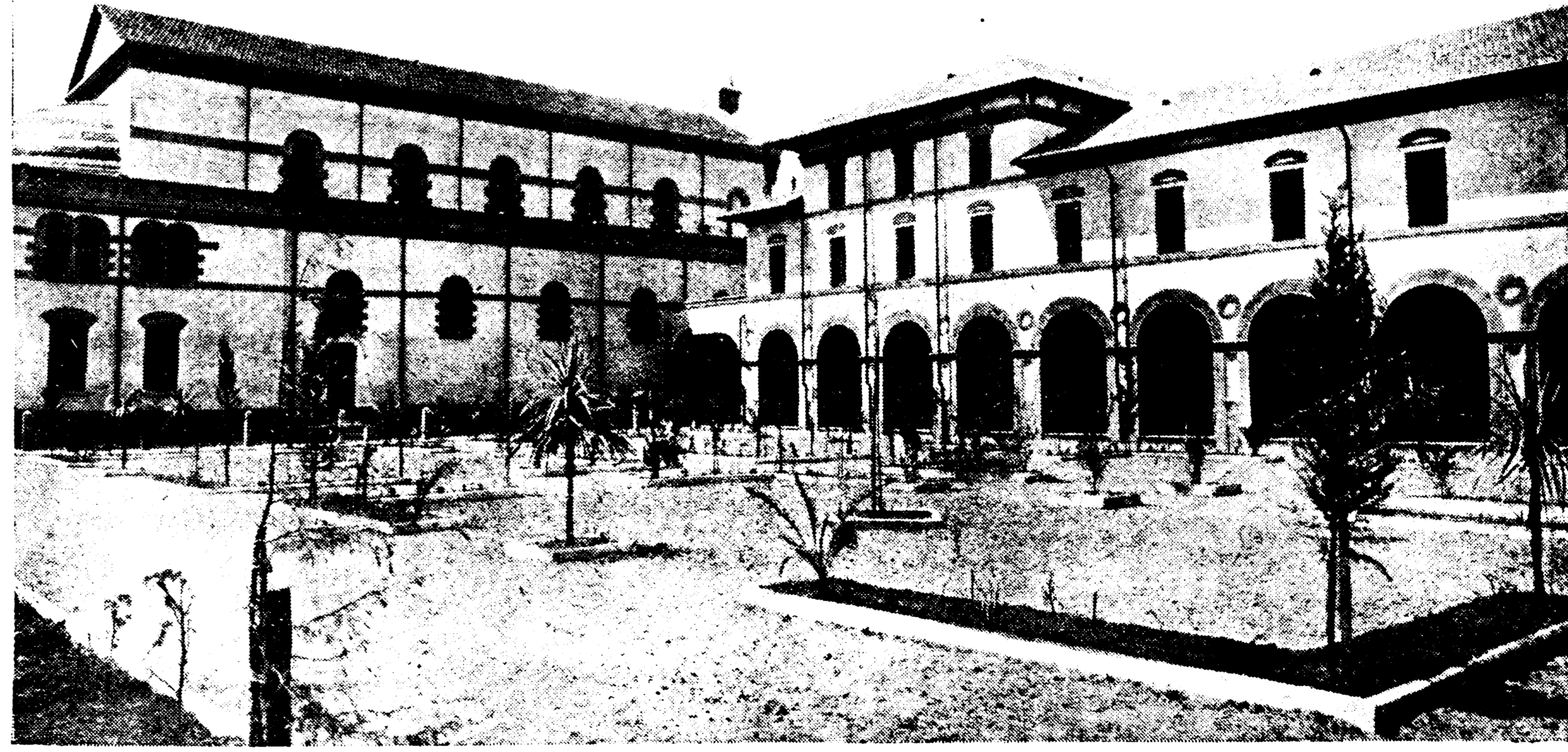
L'interno della Casa di Brindisi con un fianco del magnifico tempio.
