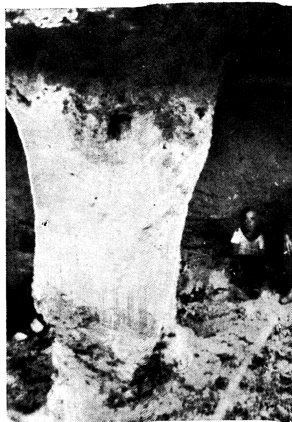
Il pilastro da sud
