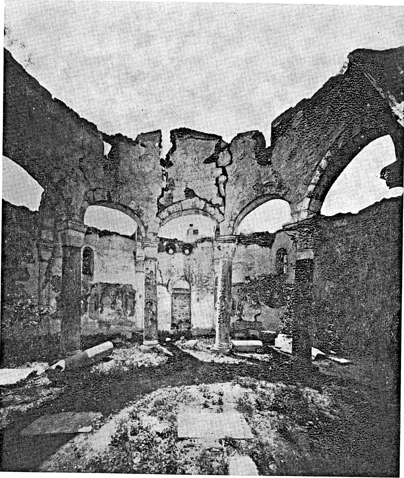
Fig. 1 - Brindisi - S. Giovanni del Sepolcro ( prima dei lavori di restauro )
