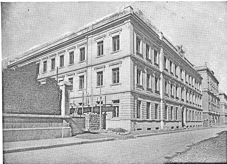
BARI - Edificio scolastico « G. Mazzini ».
