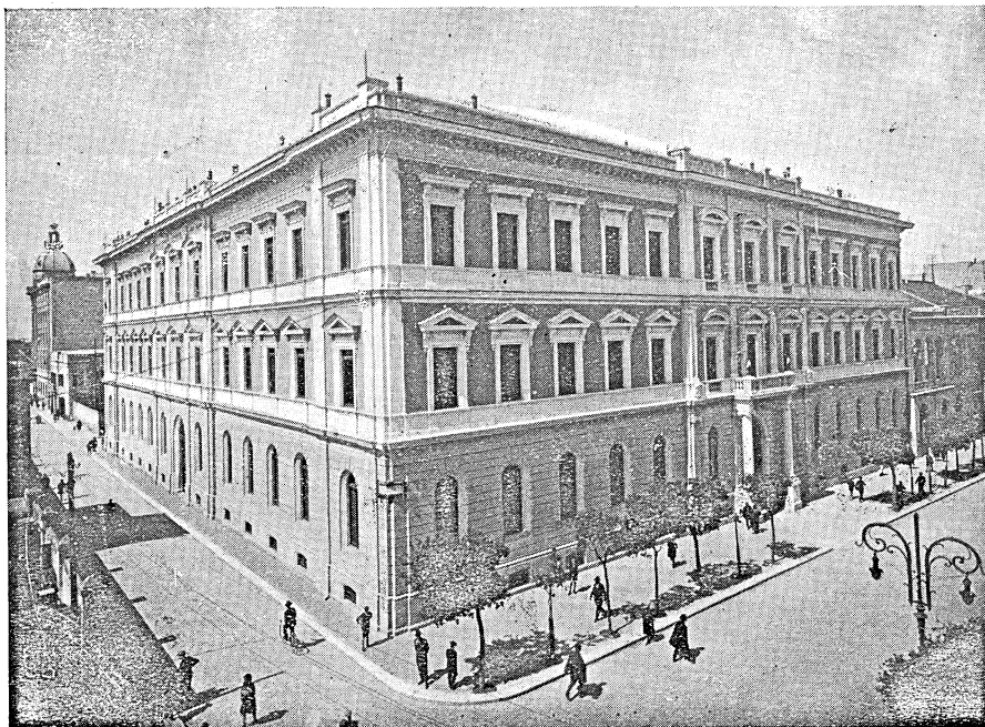
BARI - R. Istituto tecnico (Amministrazione Provinciale).
