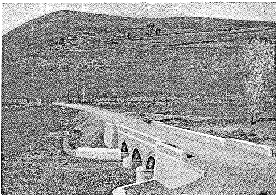
Nuovo ponte sul Tiera lungo l'Appulo-lucana.
