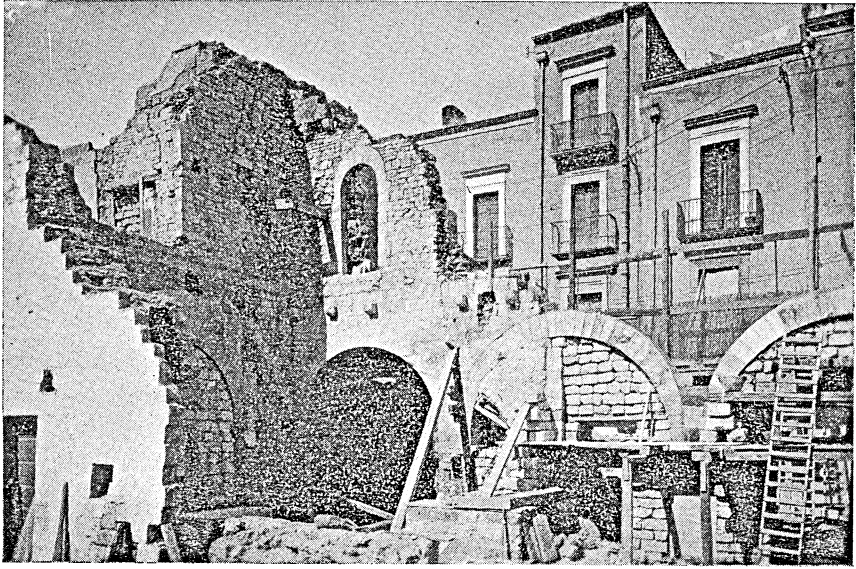
Le parti intatte dell'edificio durante la ricostruzione.
