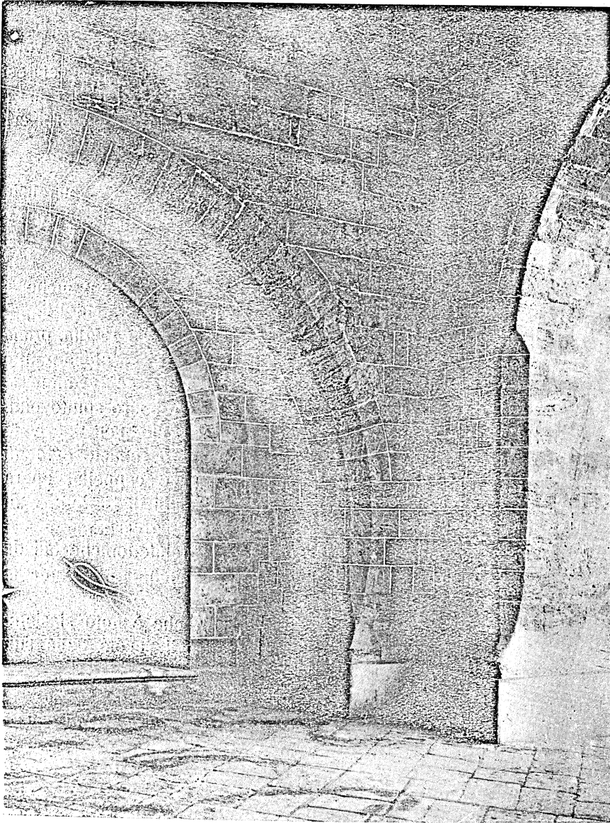
Fig. 10. — L'androne d'accesso al castello con l'ingresso alla cappella.
