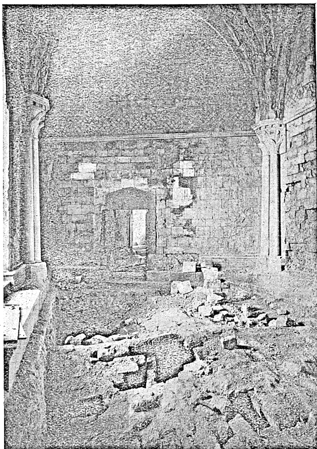
Fig. 12. — Scoperchiamento delle volte per la sostituzione dei tufl corrosi.
