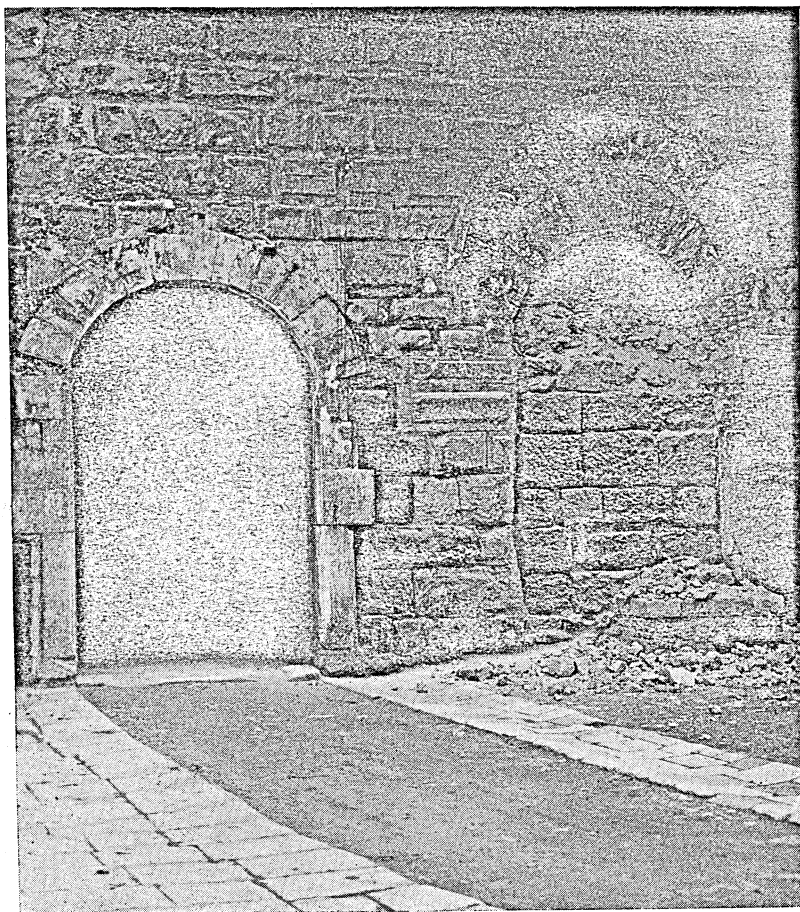
Fig. 1. — BARI. Castello Svevo. Ingresso al cortile durante i lavori di restauro.
